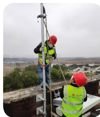
火神山醫院通信網絡施工現場
